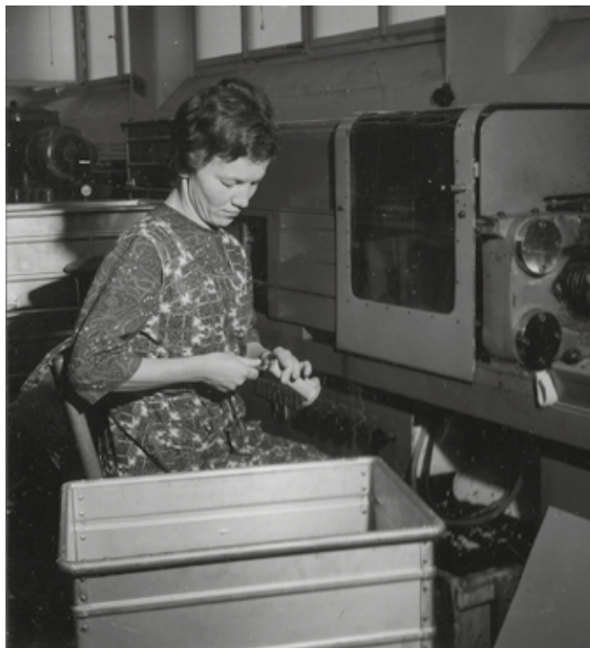
Kunststofffertigung in den 1960er Jahren.
